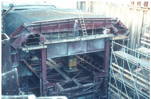
Exkursion zum Schnellfahrstreckenbau 1984, hier Forster Tunnel nördlich von KA: Bauen im Grundwasser; Foto: Heiko Jacobs
