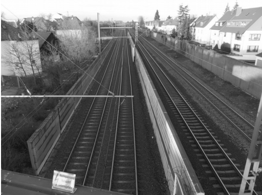
Schon vier Gleise in Hagsfeld, eigentlich zu eng für weitere zwei Gleise; Foto Dez. 2012: Heiko Jacobs
